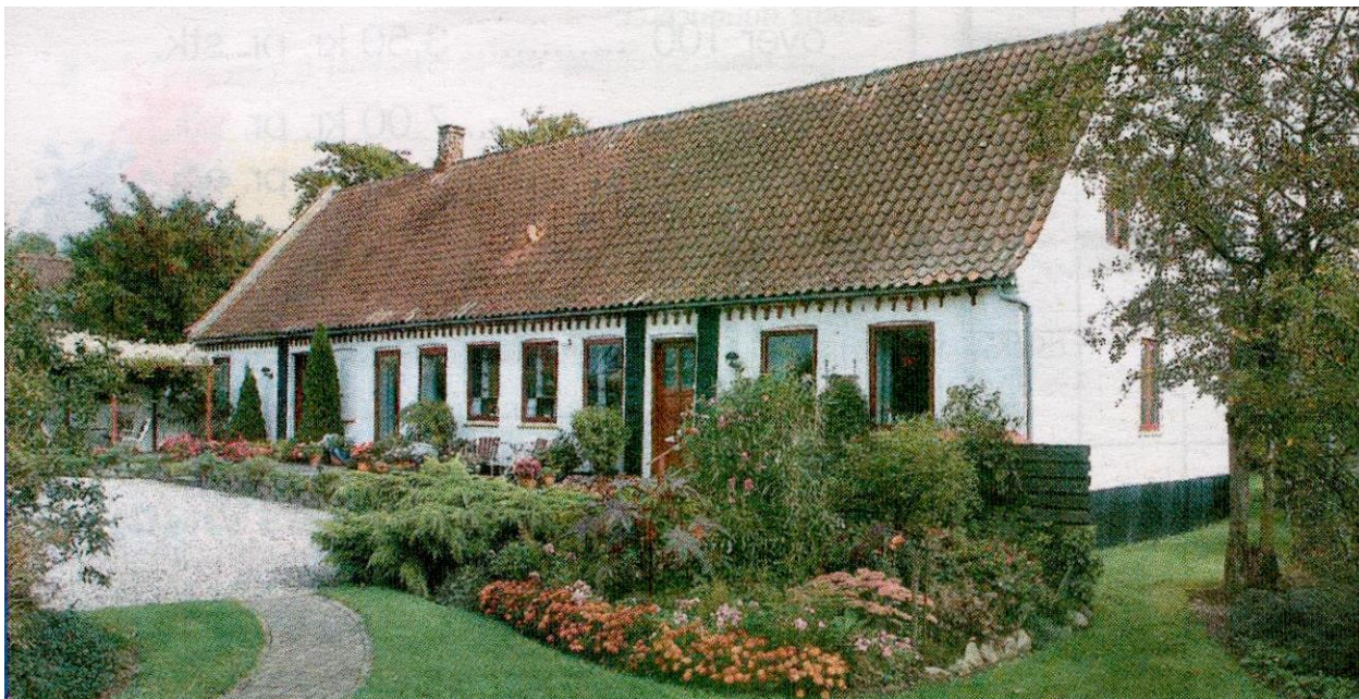
Gl. Hovedvej 16, stuehuset til den gamle gård er velbevaret. Fra salgsannonce 2006.
