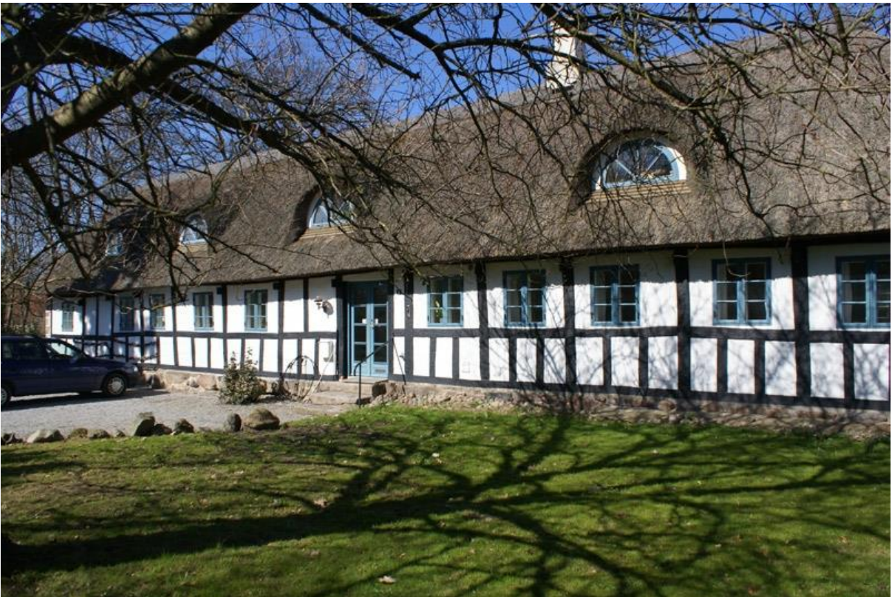
Elmebakken 5, det oprindelige stuehus til Følle Højgaard, foto ved Helge Buch Rasmussen 2010.
