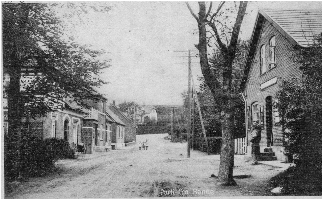
Figur 9. Molsvej ca. 1910, købmandsbutikken til højre, til venstre urmager Madsens nybyggede villa, for enden af Molsvej skimtes manufakturhandler Bundgaards også nybyggede villa.
