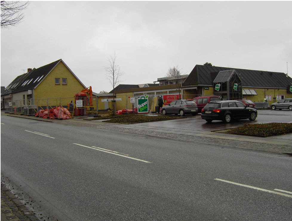
Figur 7. Suårbest udvider februar 2009, Per Høst hus er nedrevet og nybyggeriet går i gang.
