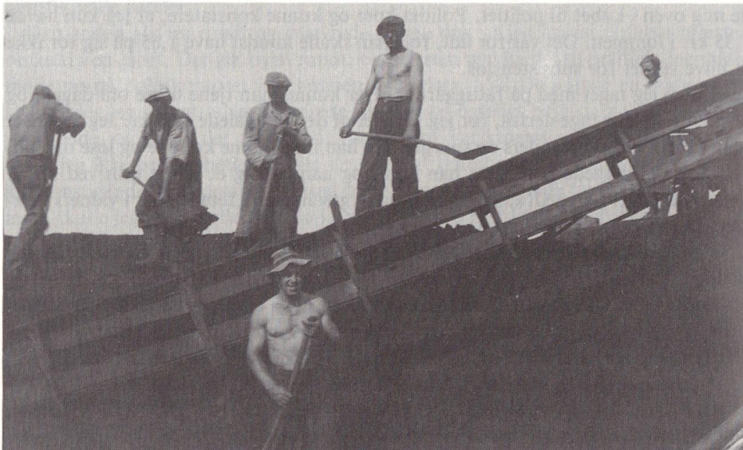
Figur 4. Tronholm. Nede i graven Sigurd Berg, ovenover fra højre brødrene Herman og Ove Andersen, derefter Svend Erik Bach. Transportøren her er til skæretørv, skåret direkte ud af jorden, og bruges til at transportere tørvene op af tørvegraven.
