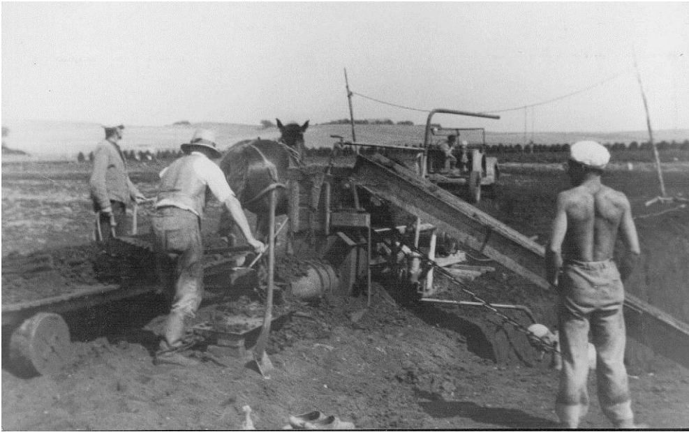
Figur 7. Pressetørv. Samme tørvepresser som på forrige billede. En af folkene vides at være Martinus Madsen, formodentlig yderst til venstre med tømmerne, jf. andre billeder. Manden i midten er tydeligvis samme person som på billedet ovenover til højre. Transportøren til højre transporterer smuldet op i presseren, og de pressede tørv afhentes af vognen til venstre og lægges ud på tørrepladsen. I baggrunden anes den firehjulstrækker, som ses på figur 2, hvor Enevoldsens lastbil trækkes fri.
