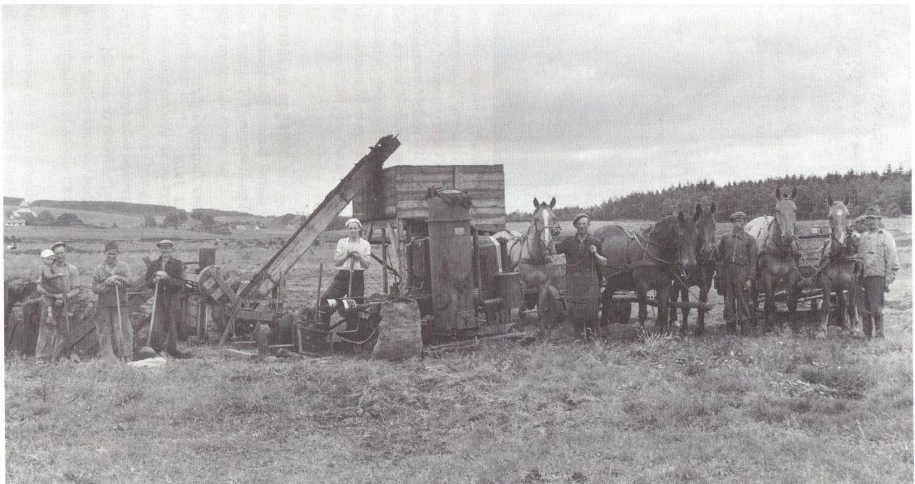
Figur 3. Dette billede er fra tørvværket ude ved "Niels i Svinget", på nordsiden af Ryomvej, ved den senere losseplads, ca. 1944. Tørvmassen blev ved hjælp af transportøren til venstre hældt ned i den store kasse, hvor den æltes og derefter hentede af dyndvogne, der kørte den ud på liggepladsen. Der ses fra venstre vognmand Poul Andersen med sønnen Tonny på armen (senere mekaniker i Skrejrup), tørvefabrikant Arne Kramer, Søren Kristiansen, ukendt, Ove Andersen, Regner Christensen og Christian Therkildsen. Fra Rita Vinding: Arbejdsmænd på Røndeegnen, SID 1996.
