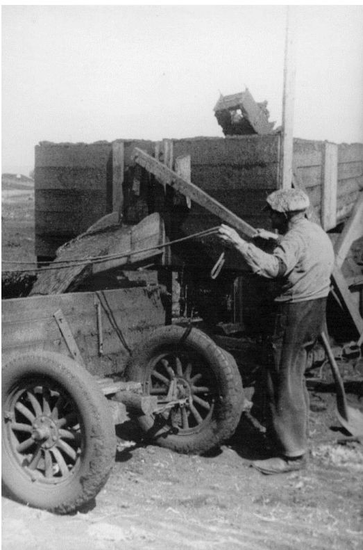
Figur 5 (til venstre): Tronholm. Dyndvognen henter æltet tørvemasse fra tørvværket. Peter Jacobsen har åbnet for spjældet, så tørvemassen strømmer ud i vognen. I baggrunden anes den transportør, der transporterer den uæltede tørvemasse op i tørvværket. Resultatet er såkaldte "æltetørv".
