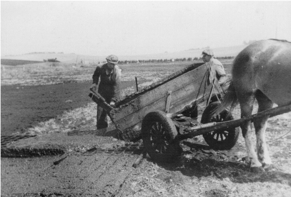
Figur 15. "Opfinderen" Øjvind Schøler havde konstrueret en dyndvogn, der kunne tippes, så aflæsningen lettedes betydeligt. En særlig drejeskive under vognladet var hemmeligheden. Her læsses æltemassen ud over tørverammerne. Det er Peter Jacobsen, der rager tørvemassen af til venstre.
