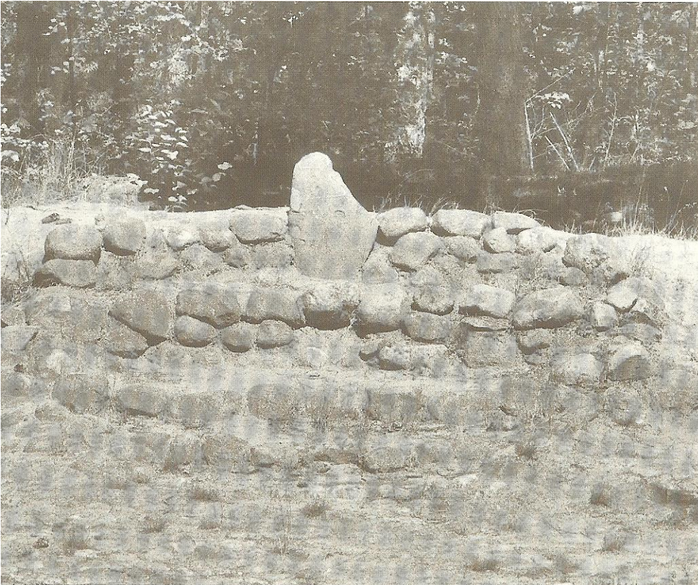
Del af Martens' lysteranlæg i Taastrup Granskov. Lysteranlægget består af et vidtforgrenet net af kampestensbyggede "gryder", hvor man kunne sidde og nyde sin medbragte frokost eller kaffe. I forbindelse med lysteranlægget var der en stor festplads, hvor der opbevarede borde og bænke og en jerntrefod til at sætte over et bål og lave kaffe eller mad ved. Anlægget var i brug som festplads, især ved grundlovsfester, til op i 1930'erne.
