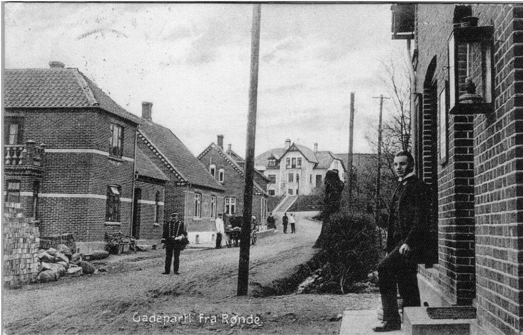
Figur 2. Molsvej ca. 1910. Til højre i billedet står købmand Hansen foran sin butik. Til venstre ses det, at urmager Madsens hus er under opførelse. Hvornår købmandsbutikken på Molsvej er etableret, vides ikke, men det kan være tidligt efter næringsfrihedsloven i 1857, idet Molsvej er det ældste Rønne. Første hus i det nye Rønne langs den nye hovedgade er kroen (senere hotellet), der er opført i 1855. De næste huse op mod Hovedgaden er Ras Savskærers (nr. 7), Nørgaards Trikotage (nr. 5), og derefter hhv. seos og dyrlægens huse nr. 3 og 1, der ikke ses på billedet.
