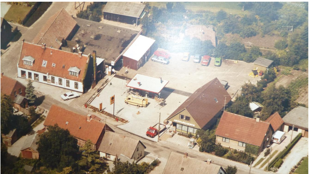
Thorsager ca. 1985. Andelskassen har fået overtaget, og kommunen har ragt både den gamle kørestald og motormøllen ned. Vi har ragt Fogeds gamle trælastbygning ned og bygget en helt ny butik på den gamle gårdsplads og hvor trælastbygningerne havde været, og butiksindgangen er flyttet herom. "Knasten" ud mod parkeringspladsen var til haveting og blev fjernet om vinteren. Fru Bachs hus er købt og ragt ned, så der nu er ved at blive opført et nyt selvbetjeningsbenzinanlæg ud mod gaden, mens fru Bachs have er blevet til parkeringsplads. Fru Bachs jord ned i Enghaven mageskiftede vi med kommunen, så vi i stedet fik resterne af
