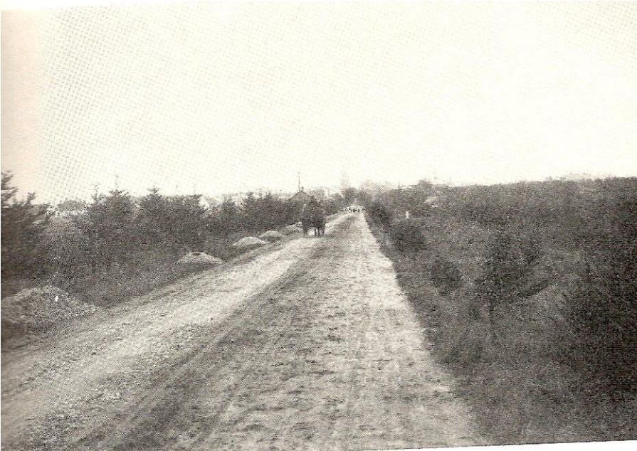
5. Nyanlagt landevej ved Herning - sådan har den nye Århus-Grenaa-landevej formodentlig også set ud...
