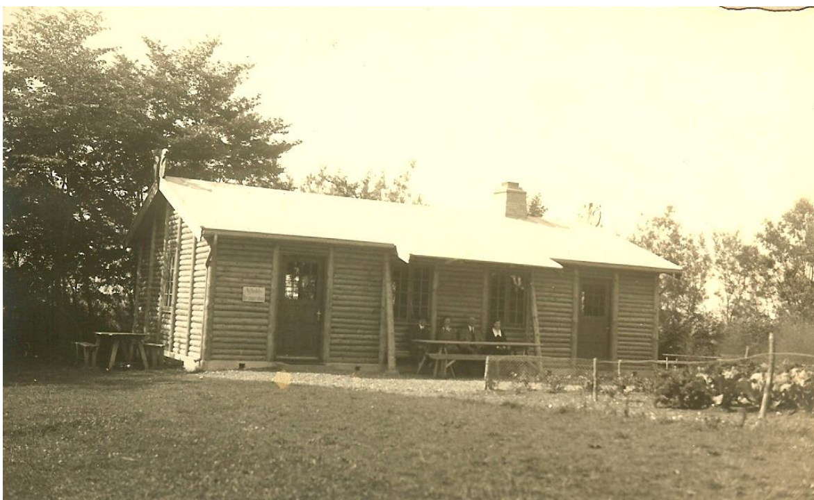
Niels Lunds traktørsted, den senere Slotskroen, 1926. Bygningen rejst ca. dette år. Det er formodentlig familien Lund, der sidder foran bygningen, Niels Lund og fru Lund, samt døtrene Olga og Musse, der drev traktørstedet videre efter forældrene, helt til omkring 1970.
