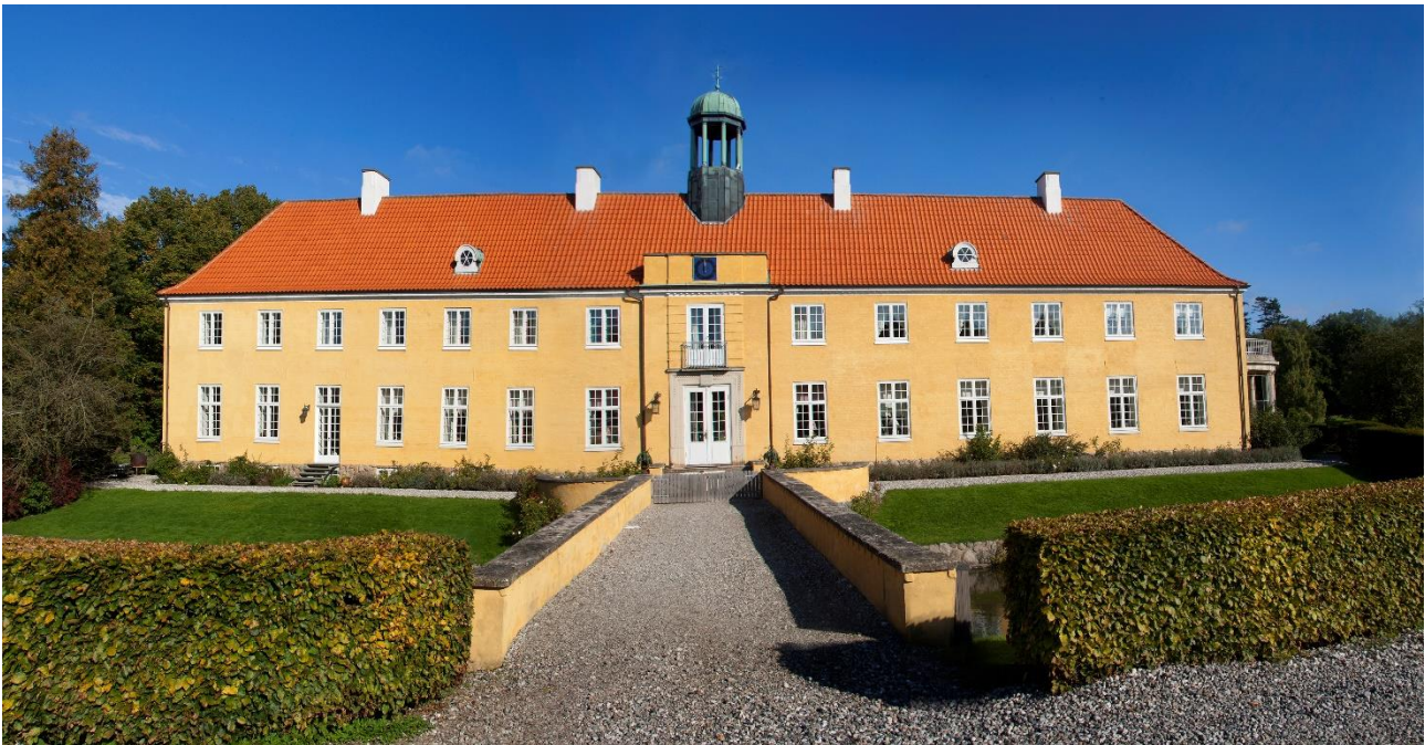
Figur 6. Møllerups hovedbygning i dag – stort set samme udseende som efter restaureringen 1920-21.
