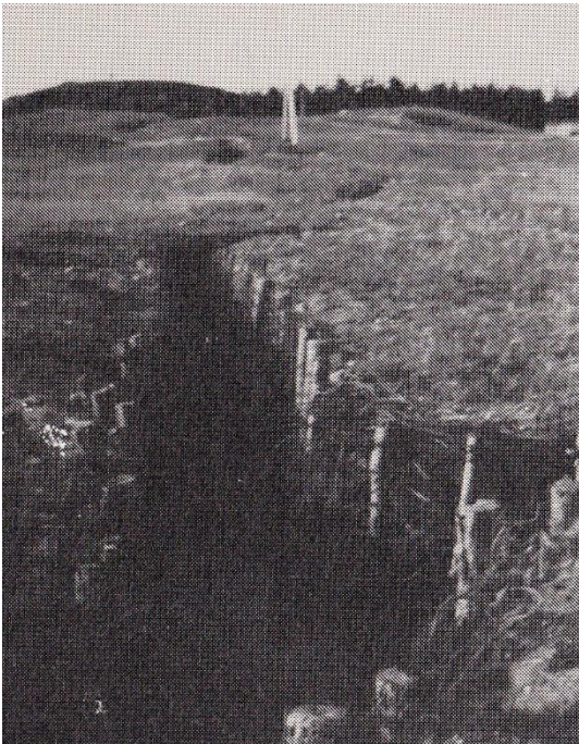
Figur 5. Hele området i den nordlige del af flyvepladsen (nu uden for lufthavnsområdet) var oversået med løbegrave forstærket med granstammer og faskiner, og mandskabsrum og depoter med jævne mellemrum. De forbandt bunkers, kanon- og maskingeværstillinger. De blev alle jævnet med jorden efter krigen, og der er næsten ikke spor efter dem i dag. I baggrunden ses den tildækkede bunker på Ildbjerg. Foto fra Bødker.
