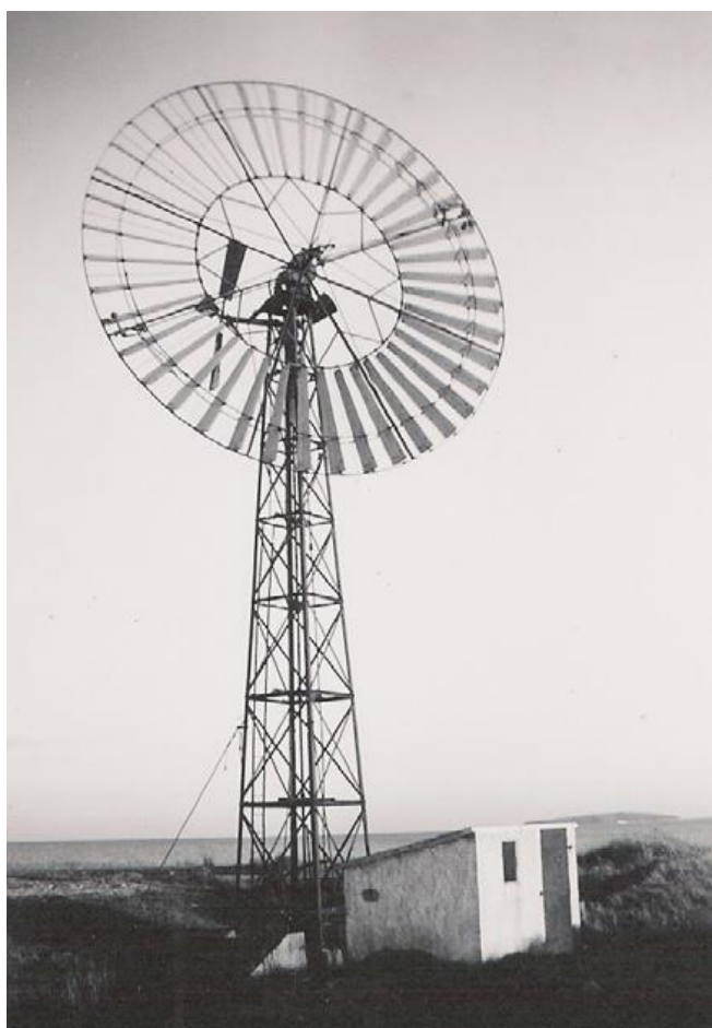
Vindmøllen fra 1899, fungerede indtil den nye afvandning i 1940'erne. Pumpehuset er i dag læskur for fårene. Fra Kjeld Hansen: Folk og Fortællinger, 2001.
