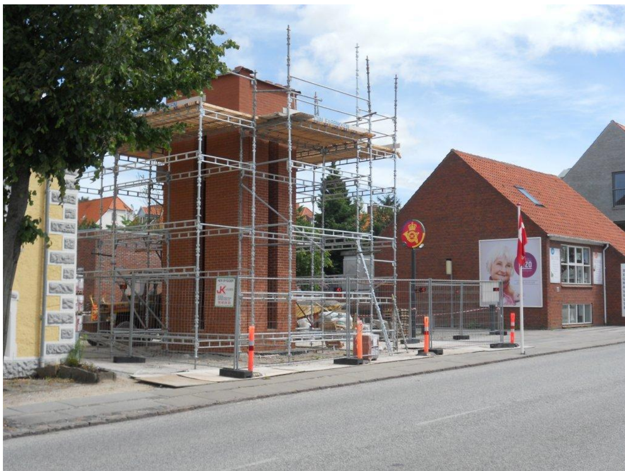
Det første tårn under opførelse på Kaløtorvet, juni 2012
