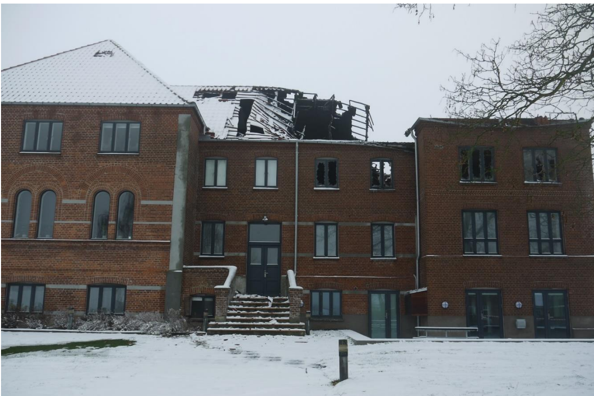
Figur 2. Efterskolens bygning ud mod Skolevej.
