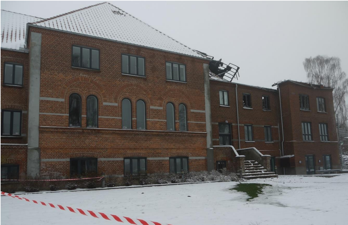
Figur 1. Branden brød ud i efterskolens bygning fredag 25. januar omkring kl. 20. De følgende billeder er taget af Vilfred Friborg Hansen dagen efter ved 14-tiden. Her hovedbygningens midterfløj, til højre efterskolens brandødelagte bygning.
