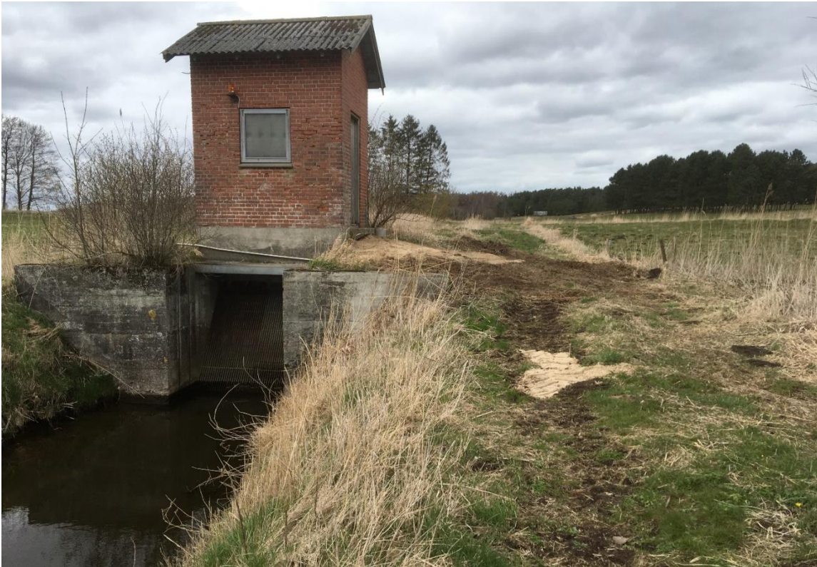
Pumpehuset fotograferet fra syd mod nord, foto VFH maj 2021.
