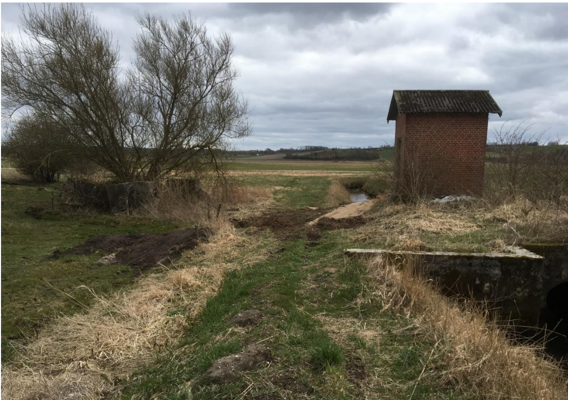
Pumpehuset set fra nord mod syd, til venstre ruinerne af vindmøllen, der klarede pumpningen til 1938. Foto VFH maj 2021
