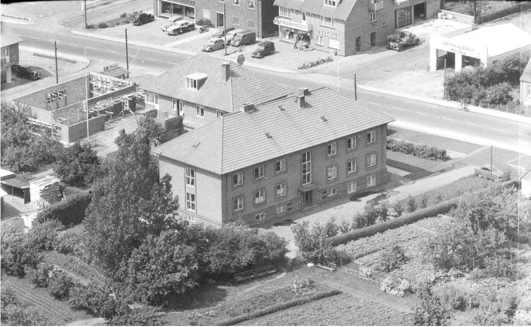
1960 er alderdomshjemmet blevet omgivet af bygninger. Aksel Jensens værksted "Autogården" ligger lige overfor. Derefter følger Valdemar Andersen med værksted og Zonen, Spar-købmanden og Arne Schous brugtbilhandel.
