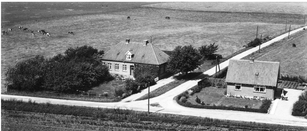
Huset til venstre er Følle Forskole, opført 1924. Det ligger på Rågholmvej, der i dag er ført højre om huset til højre i billedet. Adressen er Rågholmvej 7, nabohuset, der blev opført af familien Helbo (Følle Ladegaard) har adressen Rågholmvej 4. Forskolens beliggenhed giver mening, når man tager i betragtning, at skoledistriktet også omfattede børnene fra Skrejrup. Luftfoto 1961. Kgl. Bibl. Sml.
