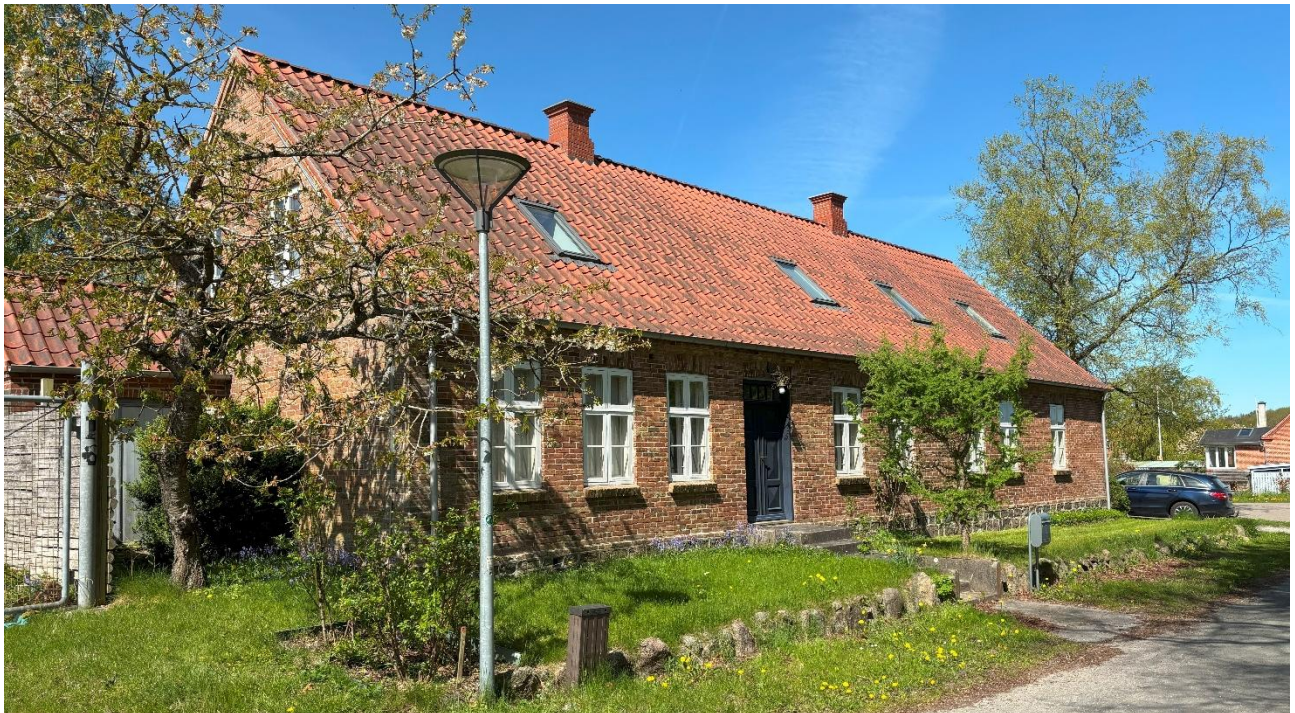
Kejlstrup gamle skole, Kærtoften 2, foto VFH april 2025.
