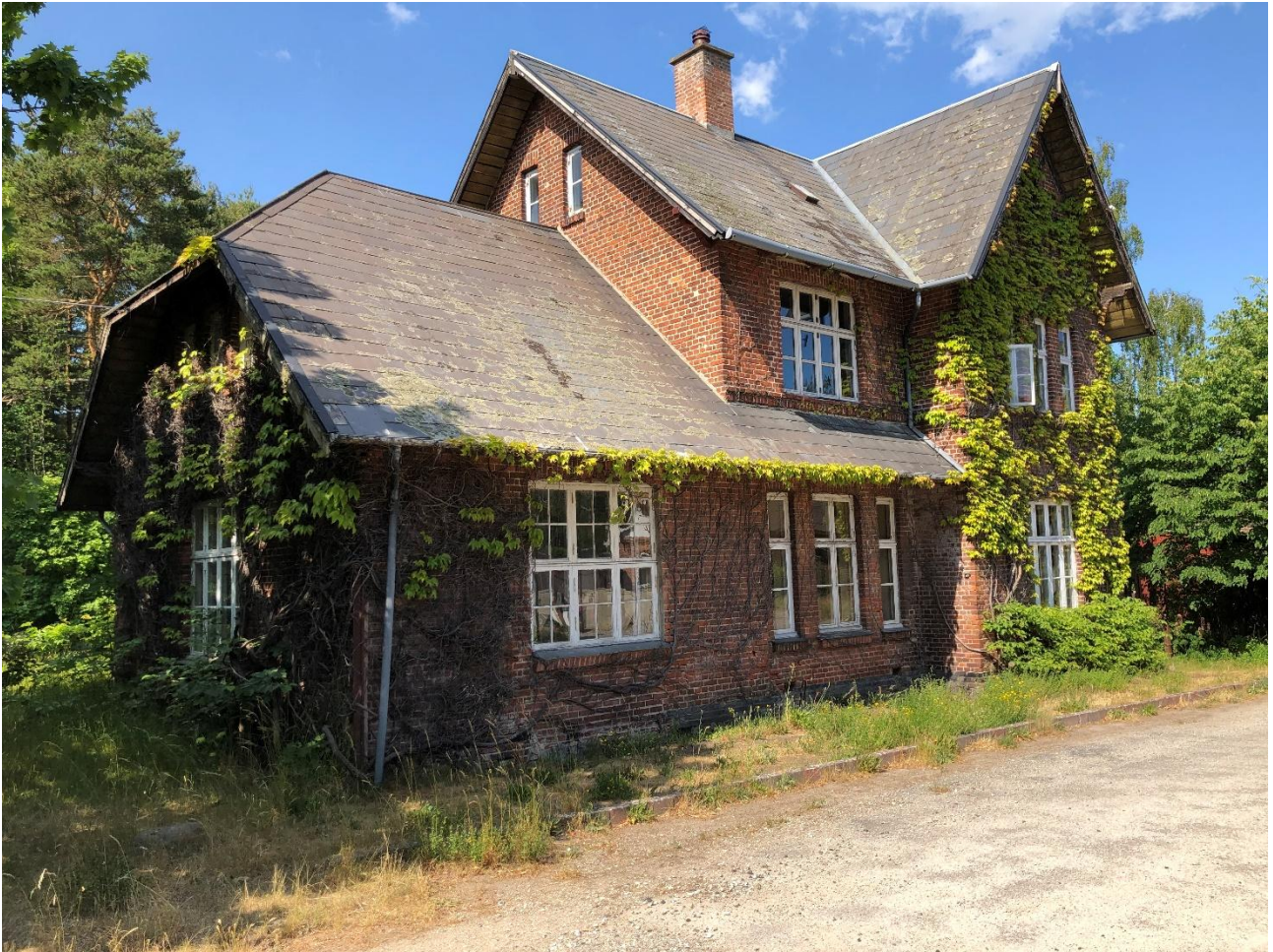
Thorsager station, som den ser ud i dag, ændret til bolig. Opført 1877. Stadigvæk en statelig bygning. Foto VFH 2023.
