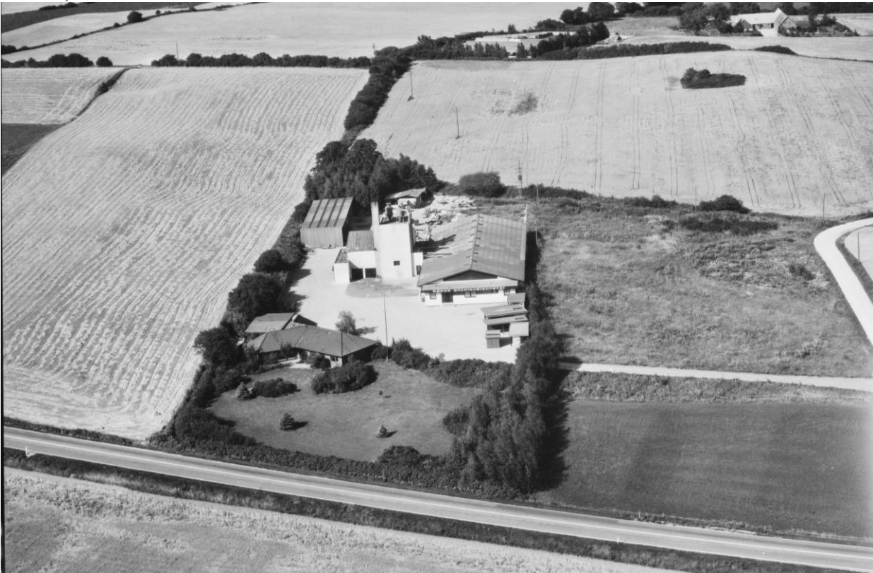
Rønde Bygningsindustri, luftfoto 1978. Kgl. Bibl. Sml.
