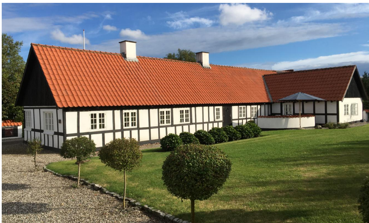
Lis og Alexanders hus har fået flere priser for respektfuld restaurering. Her foto aug. 2020 VFH. Alexander driver sit bygge- og anlægssfirma fra huset.
