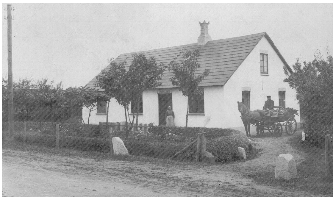
Husmandsstedet Åkjærslund, Århusvej 2, ca. 1910
