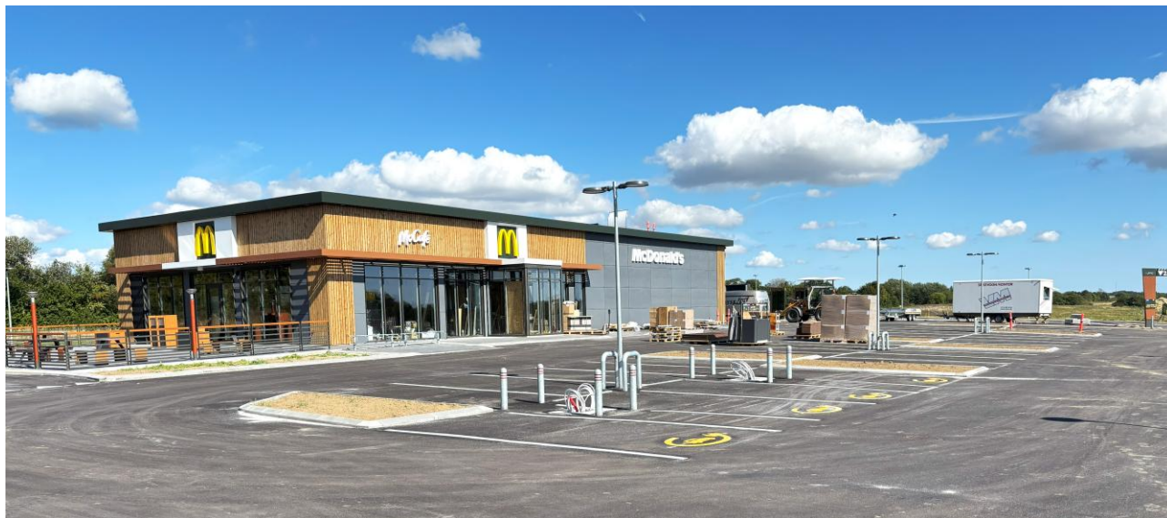
September 2025 er McDonalds stærkt på vej som det første færdige byggeri i Fremtidsparken ved Korslundkrydset i Følle. Foto 7. sept. 2025 VFH.
