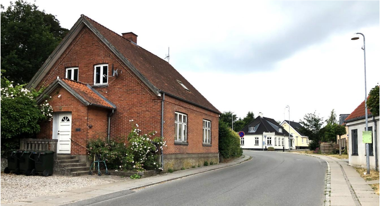
Thorsgade 43, "Post Hansens hus", foto VFH juni 2024. I baggrunden Vestergade med slagteren (senere blomsterhandel) på hjørnet. Overfor, til højre i billedet, den bevarede del af købmandsgården.
