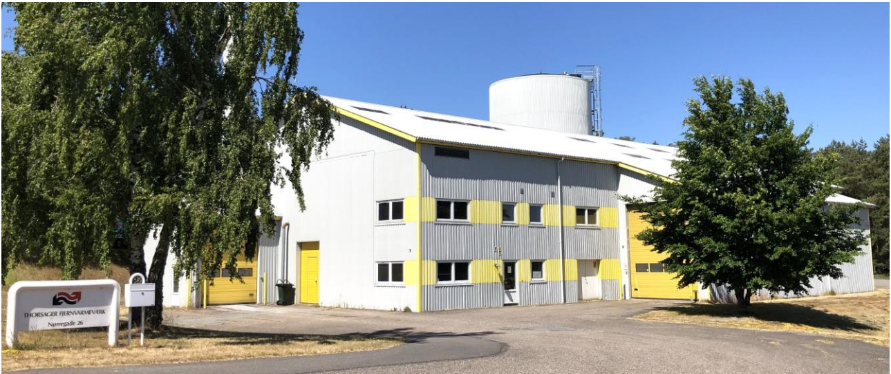
Nørregade, fjernvarmeværket Nørregade 26. Foto VFH 2023.
