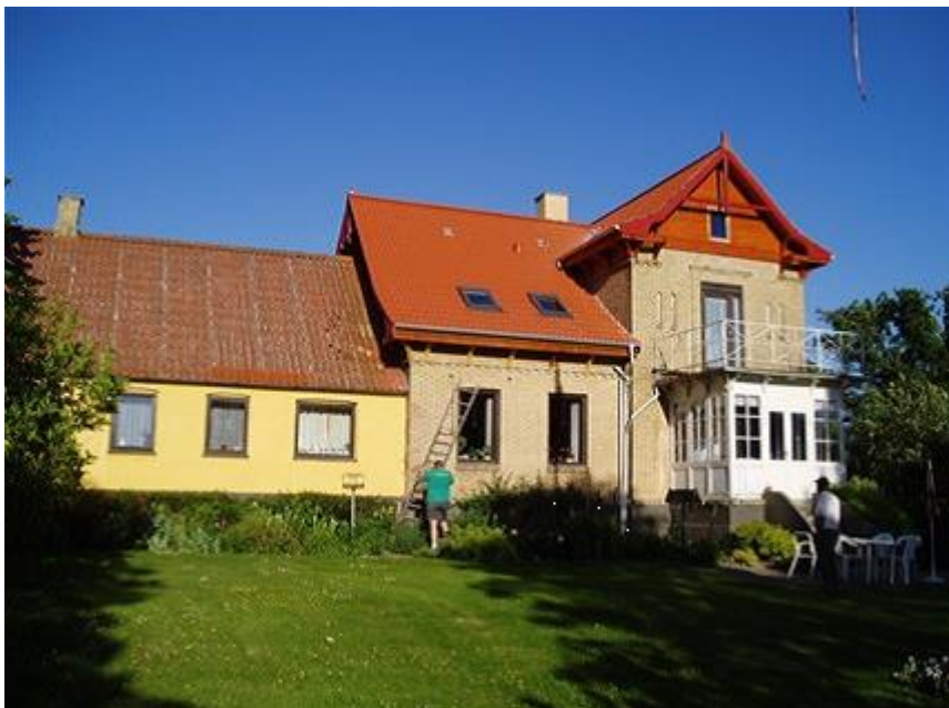
Figur 1. Kjellerupgaards nye stuehus (til højre), opført af Hans Friis 1906, bygget sammen med det gamle stuehus til venstre i billedet
