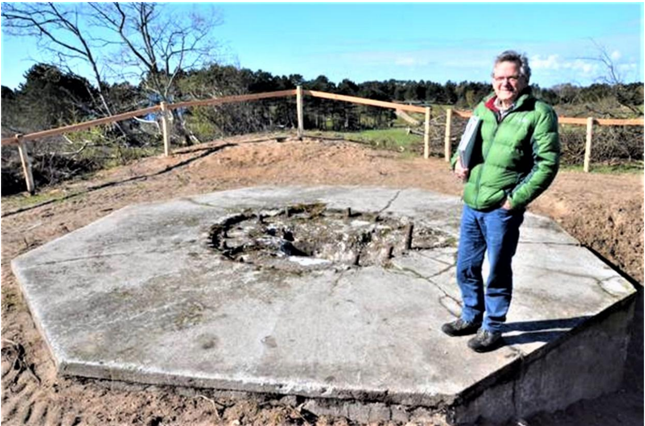
Sven Weel Jensen fra Sletterhage Fyrs Venner ved et af de udgravede betonfundamenter til en kanon ved Sletterhage. Kanonen nåede ikke at komme på før befrielsen. 2017 blev der etableret en vandrørte mellem kanonstillingerne. Sletterhage Fyr.
